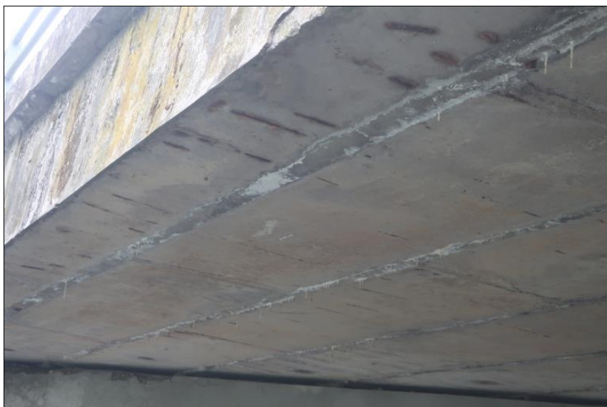
výrazné stopy po průsacích s výluhy pojiva na spodním líci spar mezi 7.-9. nosníkem.
