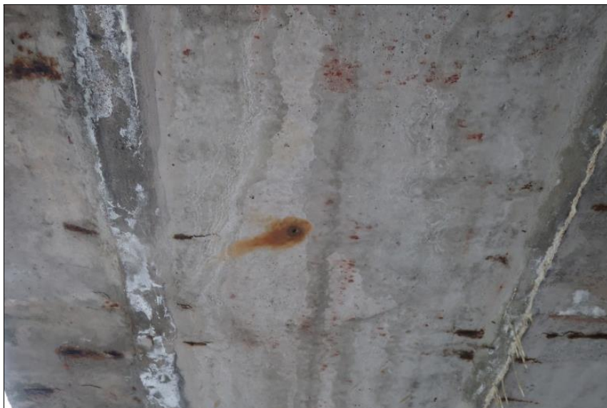
bodová koroze na spodním líci nosníku
