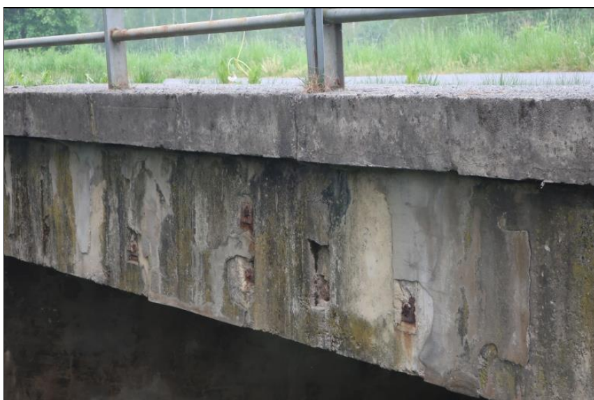
obnažené korodující kotvy příčného sepnutí na vnějším boku 1. nosníku
