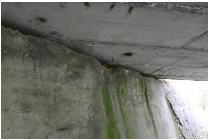
hloubková degradace betonu a nepravidelné trhliny na líci ÚP O1
