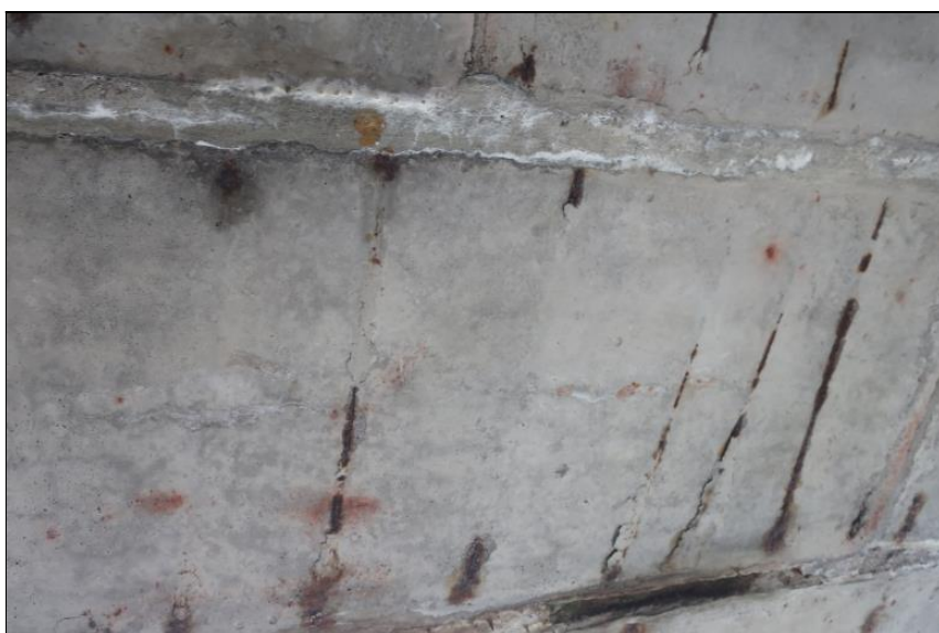
drobné výluhy pojiva v místě podélné trhliny kopírující trajektorii předpínací výztuže na spodním líci nosníku
