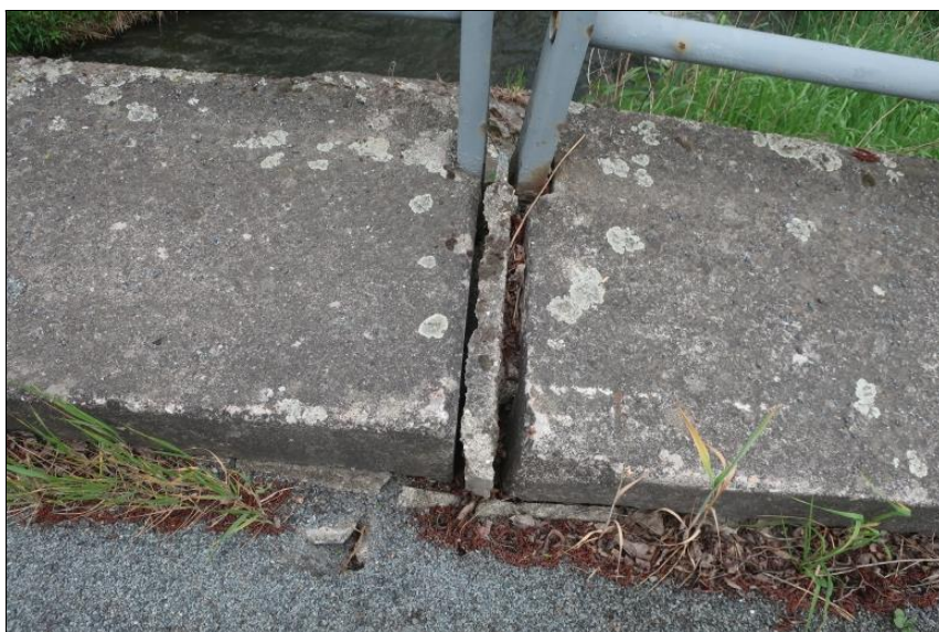
otevřená spára mezi římsovými prefabrikáty vpravo před mostem
