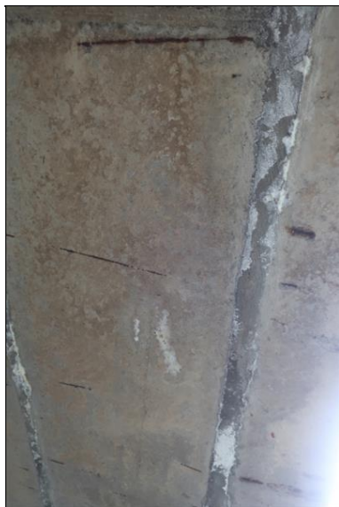
výluhy pojiva v místě trajektorie předpínacích kabelů na spodním líci nosníku
