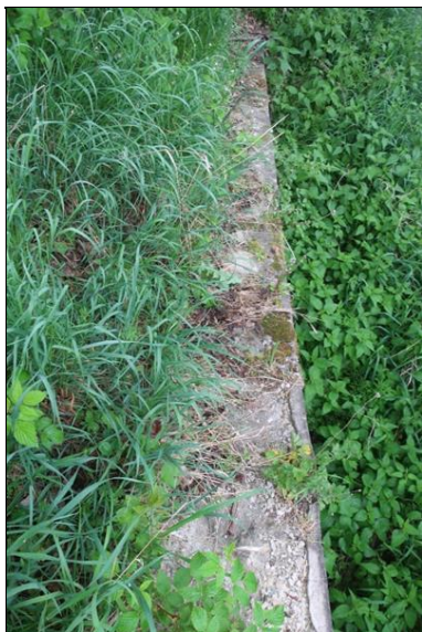
degradace betonu na horním líci levého křídla O1
