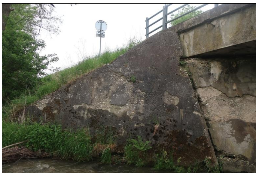
pravé křídlo O1 hloubková degradace betonu
