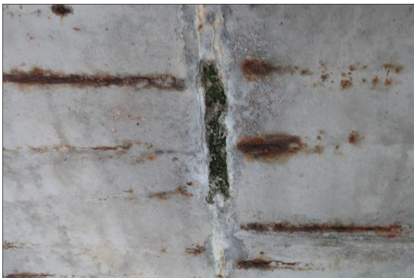
hloubková degradace betonu spáry mezi nosníky
