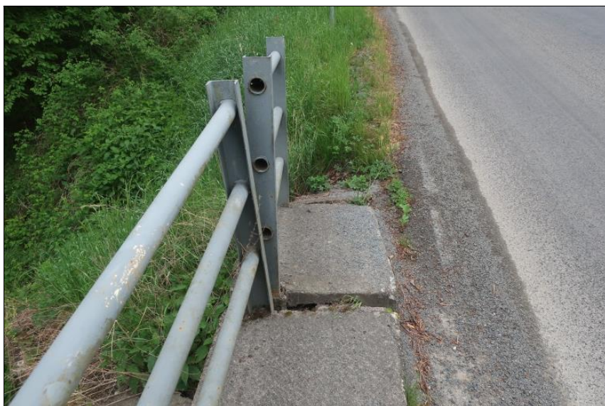
vykloněný římsový prefabrikát vlevo za mostem
