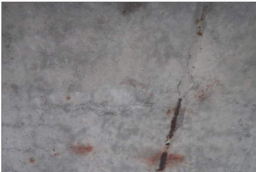
podélná trhlina se stopami po průsacích kopírující trajektorii předpínací výztuže na spodním líci nosníku
