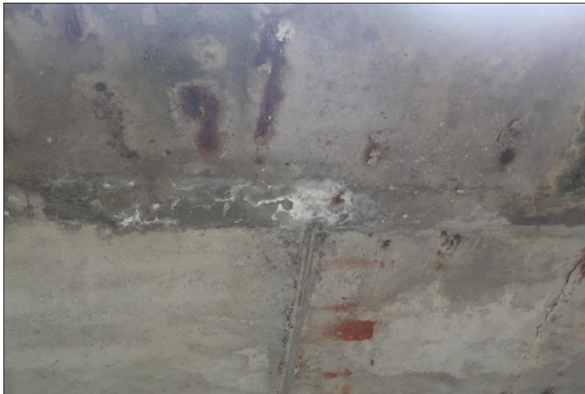
stopy po průsaku s výluhy pojiva sparou mezi 1. a 2. nosníkem koroze výztuže na spodním líci 1. nosníku
