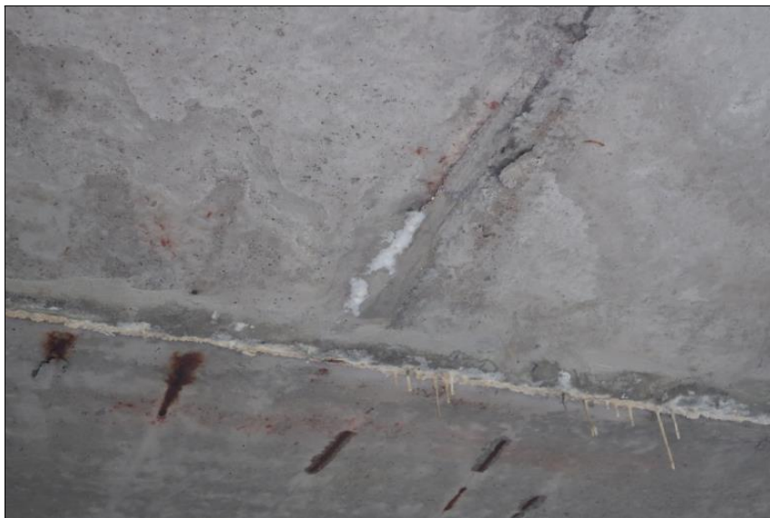
výluh pojiva na spodním líci nosníku v místě příčné pracovní spáry mezi dílci
