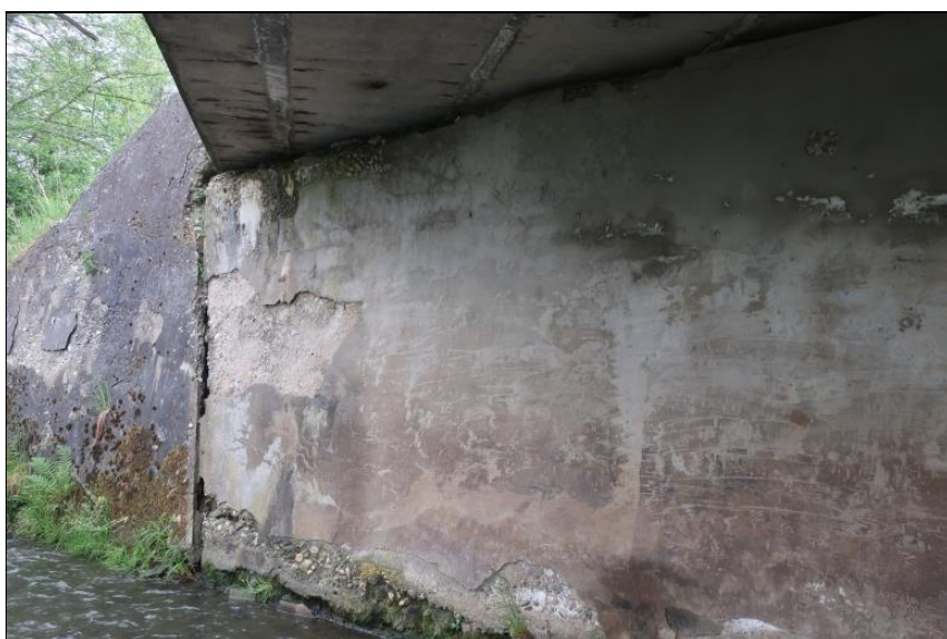
degradace betonu dříku O1 v pravé části
