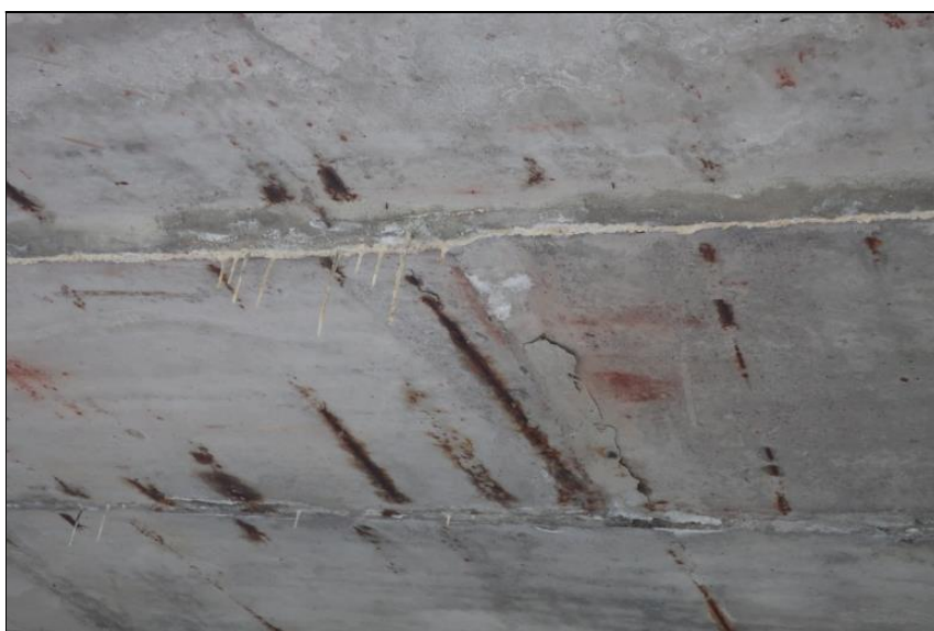
výrazné stopy po průsacích s výluhy pojiva sparami mezi nosníky intenzivní koroze konstrukční výztuže v oblasti zcela nedostatečné tloušťky krycí vrstvy
