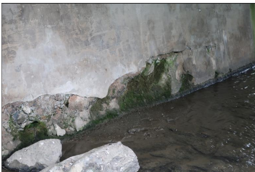
hloubková degradace betonu v patě O2
