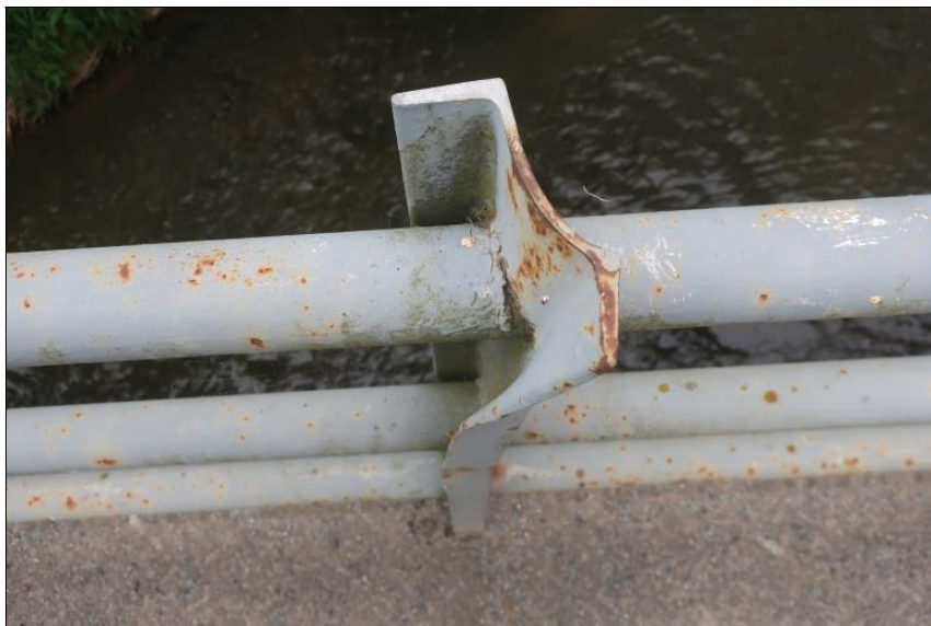
koroze zábradlí deformace sloupku
